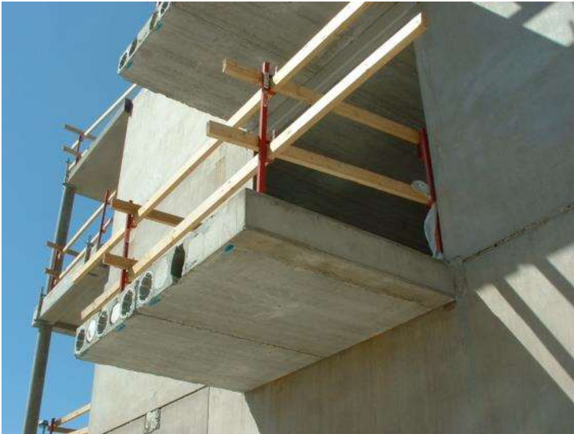
Kv. Kronolotsen 2, Malmö, Sweden (Strängbetong 2007-2008)
