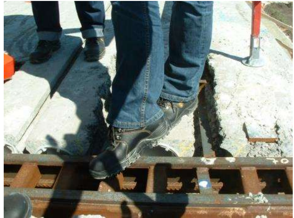
Kv. Kronolotsen 2, Malmö, Sweden (Strängbetong 2007-2008)
