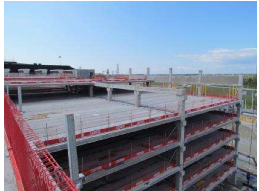
Emporia, Malmö, Sweden (Strängbetong 2008-2011)
