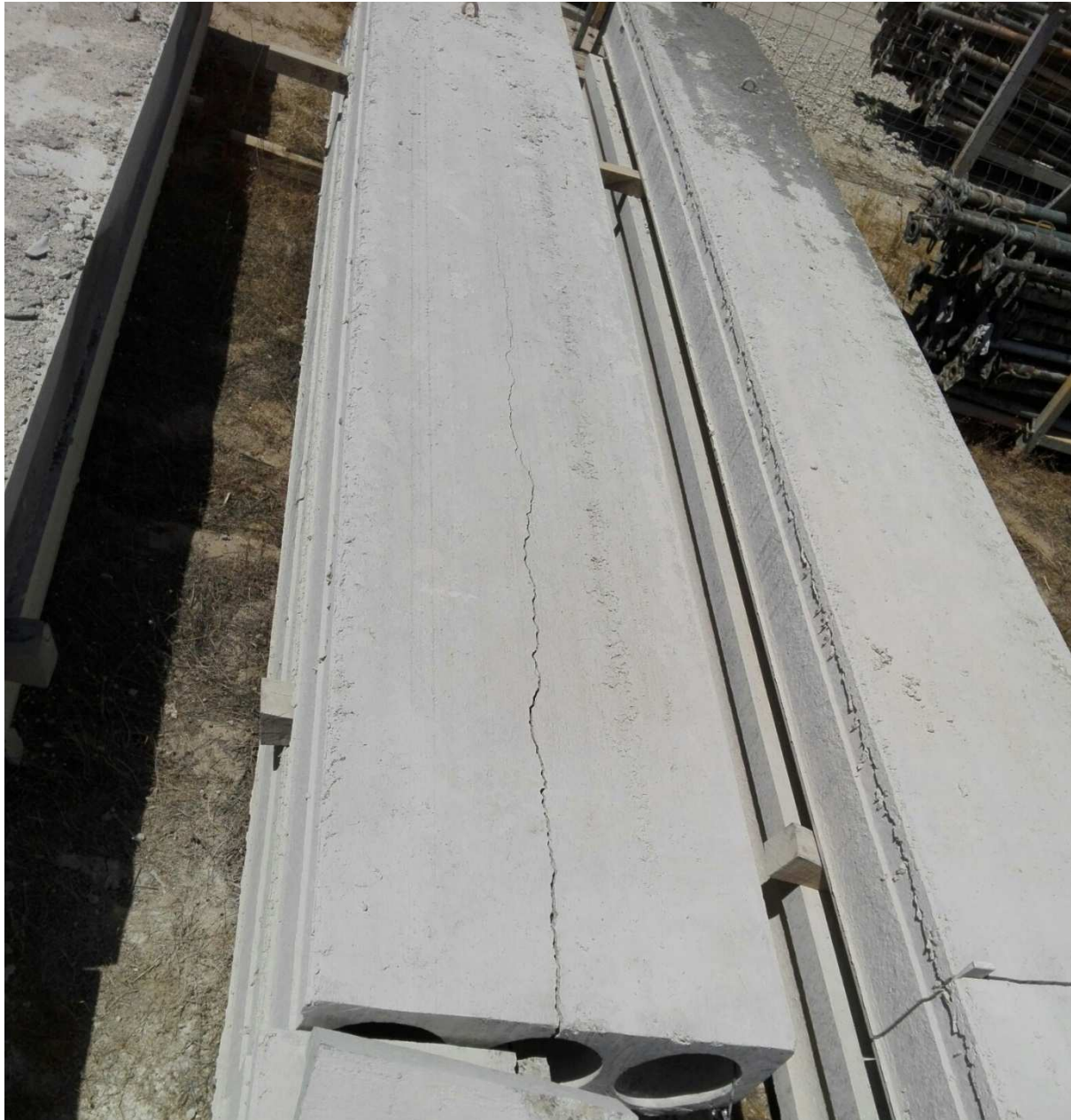
Longitudinal crack above core
